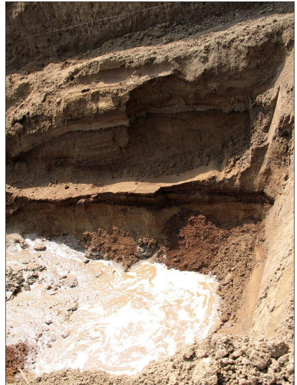
Fig. 18. Rezé, Saint-Lupien, zone 4. Exemple d'effet de sape dans des alluvions sableuses (cl. M. Monteil, 2006).
